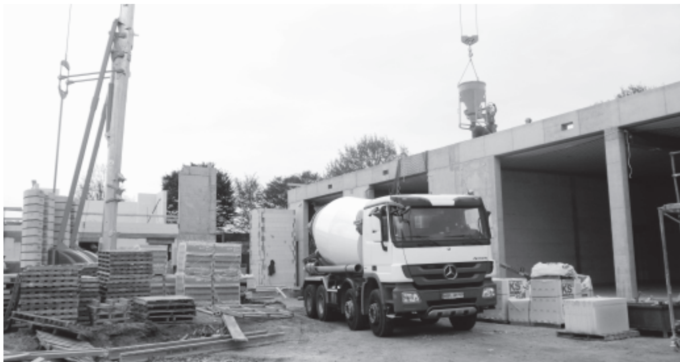
Auch hier bewegt sich endlich 'was: Nach langer Suche wurde endlich ein Platz für das neue Feuerwehrgerätehaus gefunden.
